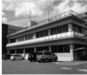
▲立田支所の解体部分
